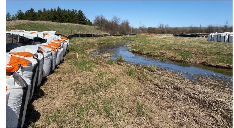
Passage supérieur temporaire d'Indian Creek avec sacs de gravillon et fondations de culée 28 avril 2022
