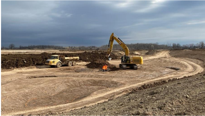
Construction hors circuit du canal de déviation du tributaire A 13 avril 2022
