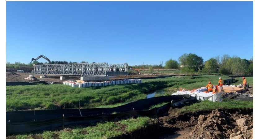
Pose d'un pont temporaire avec ouvrage de réduction d'érosion et clôture pour la faune 17 mai 2022
