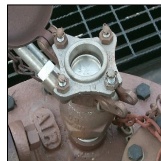
Soupape de surpression à disque de rupture
